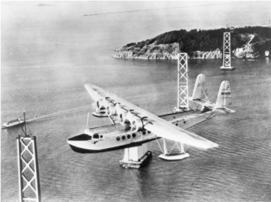
Die S-42 über der im Bau befindlichen San Francisco-Oakland Bay Bridge 1934
