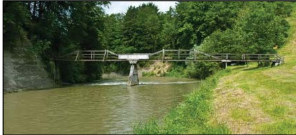
Der h lzerne, zuletzt 1914 erneuerte Blindensteg
