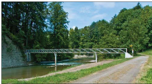
wurde 2010 durch eine 38 m lange Stahl-/Holzkonstruktion mit Pfeilern und Widerlagern aus Beton ersetzt.
